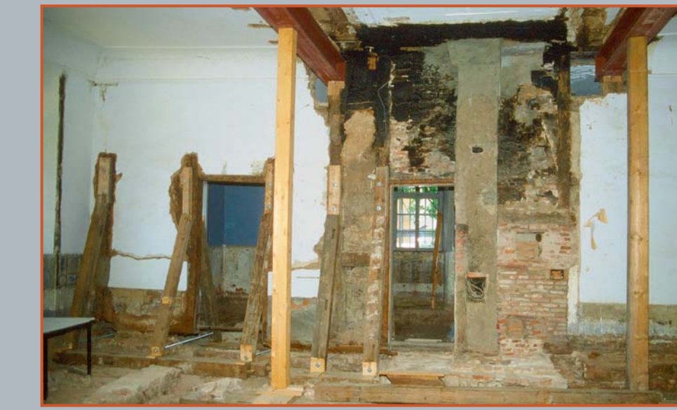
Der Abtssaal während der Baumaßnahmen
